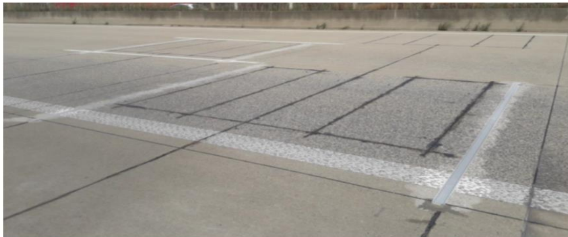
Abbildung 2: Bild der in die Fahrbahn eingebauten Wiegebalken (WIM-Anlage) (BALM)
